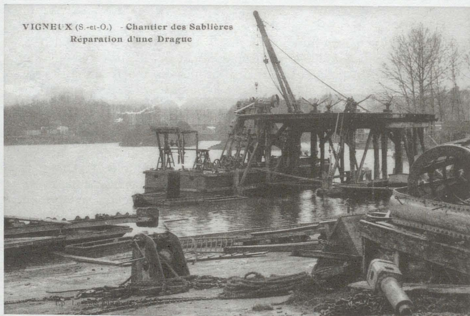
Réparation d'une drague à Vigneux, vers 1910. Coll. part.
