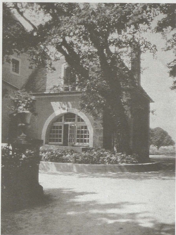
Fig. 27 – L'ancienne chapelle Sainte-Madeleine du château de Saudreville, transformée en cuisine par l'architecte Louis-Hippolyte Boileau en 1923-1925. (Collection particulière, photographie, 1929).
